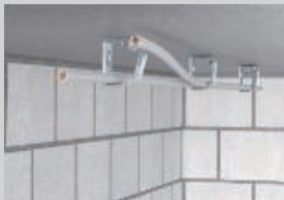
Openen van de bundelhouder en plaatsen van de kabel.
