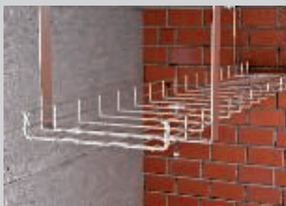
Bevestiging van de draadgoot met klemstuk en platkopschroeven.
