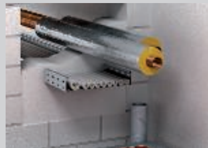
Isolatie voor metalen buizen gebruiken.
