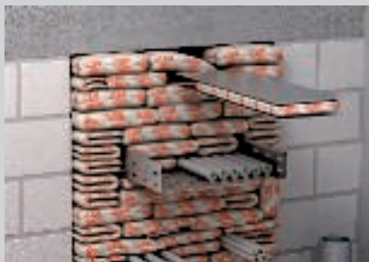
Plaat als montagehulp voor de laatste laag kussens.
