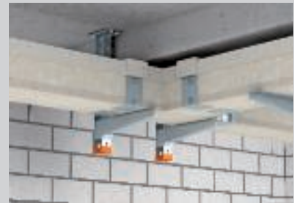
Voorgemonteerde standaard hulpstukken in het traject.
