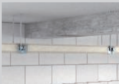
Opgehangen montage aan de verbinder-elementen.
