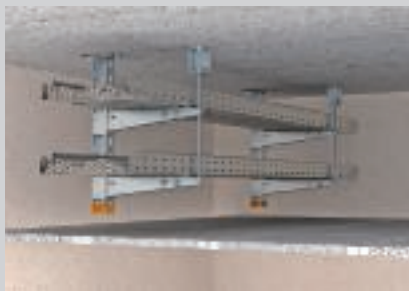
Tweelaagse plafondverlaging met aan één zijde consoles.
