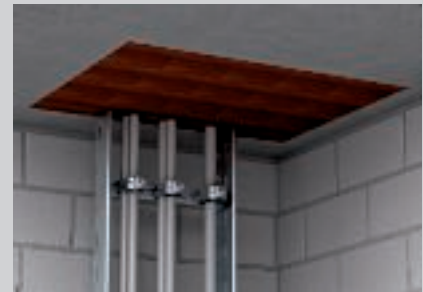
Strakke inbouw van de blokken in de plafonddoorslag.
