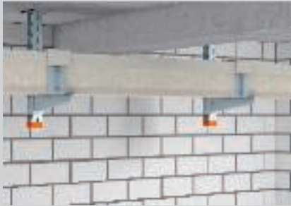
Opgehangen plafondmontage als I-kanaal.
