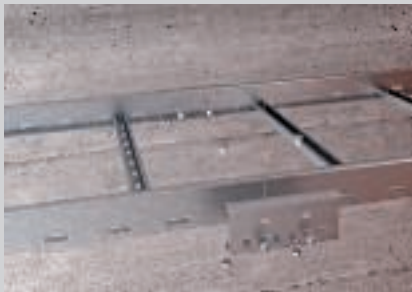
Montage van de koppelplaten met platkopschroeven.
