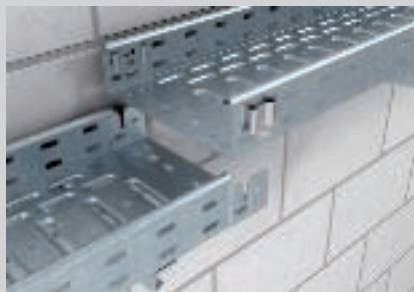
Maken van de langsverbinding door in elkaar steken van de kabelgoten.
