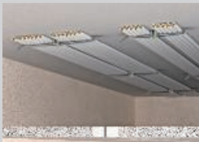
Plaatsbesparende en brandveilige montage van leidingen boven een brandwerend plafond.
