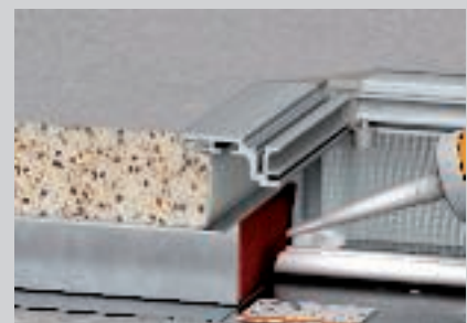
Restvoegen tussen kabels en blokken met pleistermassa FBA-SP afsluiten.
