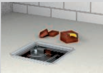
Smalle stroken voor de kanaalstukken snijden.
