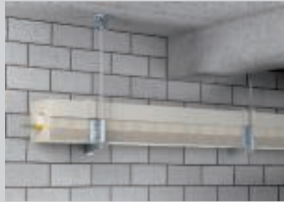
Wandmontage op consoles en extra draadstangborging.
