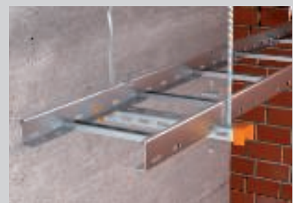
Montage op dwarsprofiel met klemstuk, platkopschroeven en grote sluitringen.
