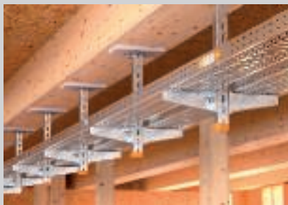
Hangprofielmontage onder de houten balken met achterliggende brandwerende plaat.
