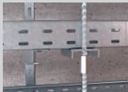
Draadstangbevestiging aan de goot bij meerlaagse opstelling.
