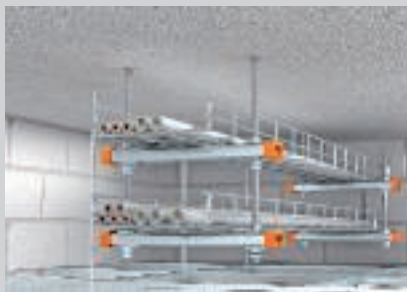
Tweelaagse plafondmontage boven verlaagd brandwerend plafond.
