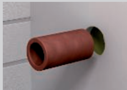
Plaatsen van de bus in de lichte scheidingswand.
