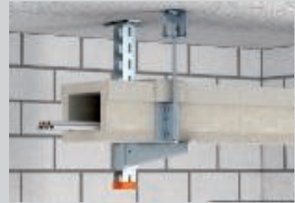
Montage als E-kanaal met extra draadstangborging.
