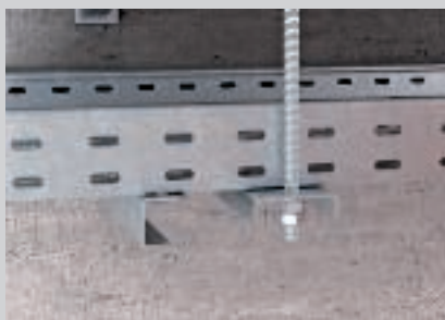
Bevestiging van de verticale draadstang op de onderste kabelgoot.
