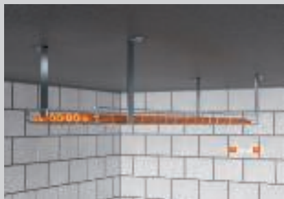
Eenlaags plafondmontage met ophangbeugel.
