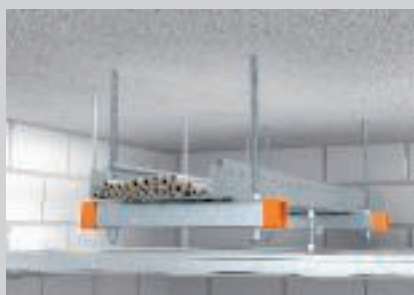
Eenlaags plafondmontage boven verlaagd brandwerend plafond.
