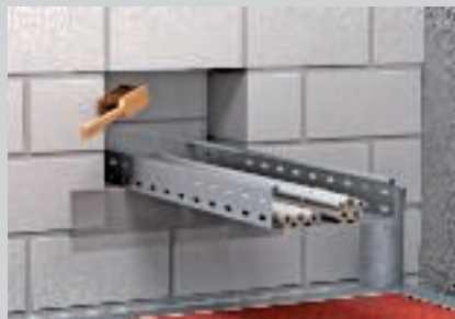
Sparing reinigen en bekistingshulpmiddelen, bijv. plakband, aanbrengen.
