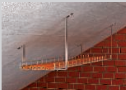
Montage onder schuin plafond met individueel aangepaste ophangbeugel.
