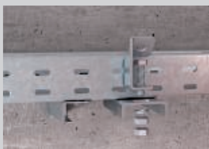
Bevestiging van het schuine aansluitdeel.
