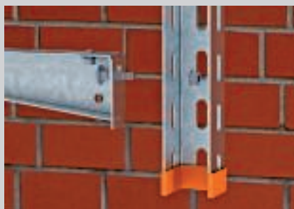
Consolemontage op het hangprofiel met platkopschroef.
