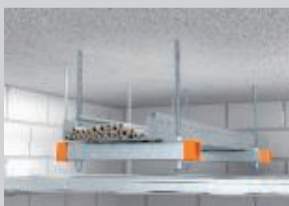
Eenlaags plafondmontage boven verlaagd brandwerend plafond.
