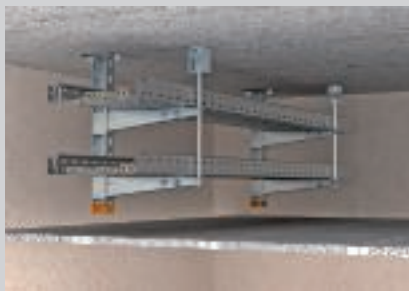
Tweelaagse plafondverlaging met aan één zijde consoles.
