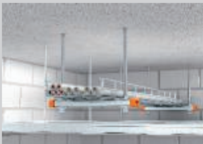
Eenlaags plafondmontage boven verlaagd brandwerend plafond.
