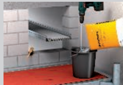
Mortel met water aanmaken, tot de gewenste stevigheid bereikt is.
