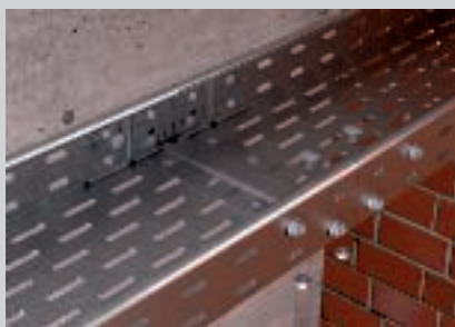
Koppelplaten en voegplaten met platkopschroeven bevestigen.
