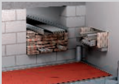
Afsluiten van de opening met kussens - zonder pleistermassa of verf.
