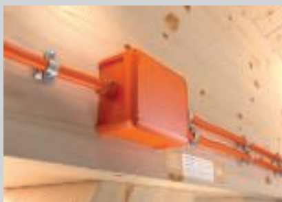
Montage van de OBO FireBox aan houten balken.
