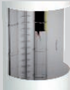
Stijgladders met bandage in de renen van een windmolen.
