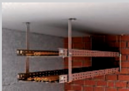
Tweelaagse plafondmontage met ophangbeugels en verlenging.
