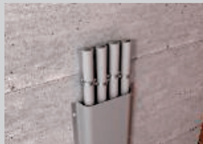
Bevestiging van de bandage met metalen rails bij een installatie met enkele klemmen.
