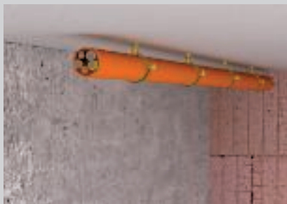
Montage aan het plafond.
