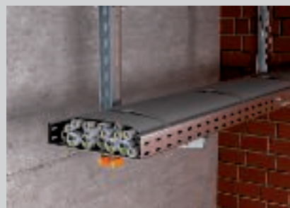
Bandage op de kabelbundels op draagsystemen aanbrengen.
