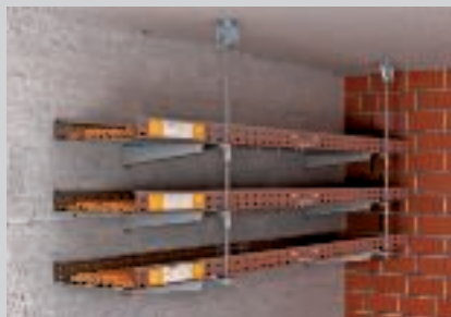
Wandmontage meerlaags met draadstangborging verticaal.
