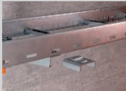
Plaatsen van het aansluitdeel op de onderkant van de ladderstijl.
