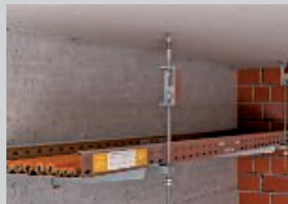
Plafondbevestiging van de draadstangen met brandwerende beugel.
