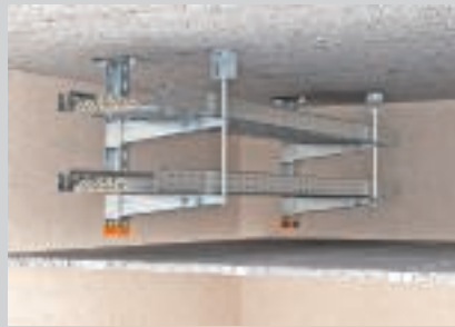
Tweelaagse plafondverlaging met aan één zijde consoles.
