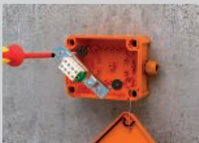
Montage met brandwerende ankerbout door beugel en bodem van de FireBox.
