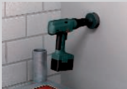
Boren van een gat met een doors- boor.
