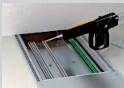
Inbrengen van het brandwerende schuim direct onder de wand.
