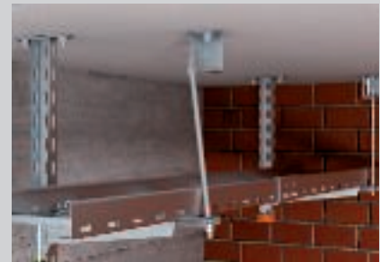
Ophangen van de draadstang in de brandwerende beugels.
