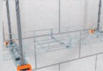
Schroefloze voegverbinding.
