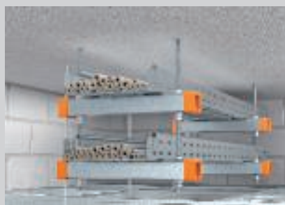
Tweelaagse plafondmontage boven verlaagd brandwerend plafond.
