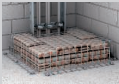
Beveiliging tegen wegglijden boven de vloer.
