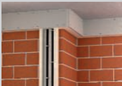
Kabelbevestiging bij verticale kanaalmontage met klemmen.
