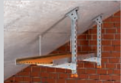
Montage onder schuine plafonds met variabele kopplaat.
