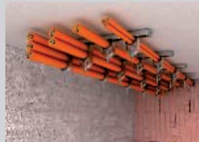
Horizontale montage van de kabels met beugelklemmen onder het plafond.
