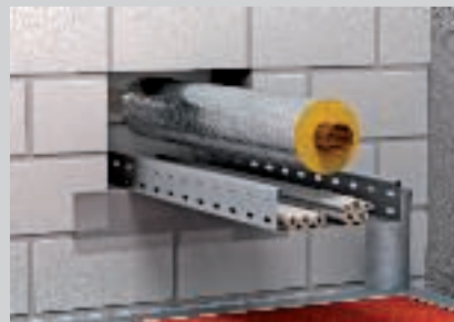
Toegestane isolatie voor metalen buizen gebruiken.
