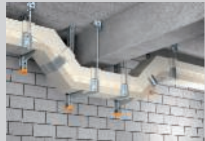
Prefab hulpstukken voor richtingsveranderingen bij hangende montage.
