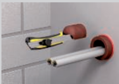
Snijden en plaatsen van de stop in de bus.
