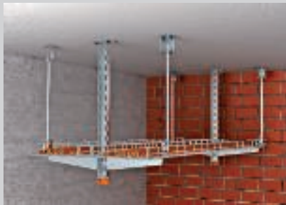
Plafondmontage met aan beide zijden opgestelde consoles.
