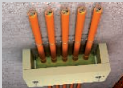
Effectieve ondersteuningsmaatregel met de trekcontlasting ZSE90.
