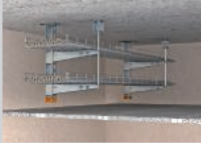
Tweelaagse plafondverlaging met aan één zijde consoles.
