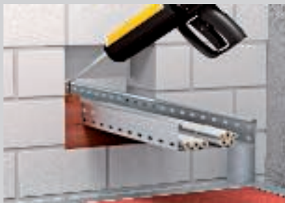
Schuim van achteren naar voren inbrengen, restanten eventueel verwijderen.
