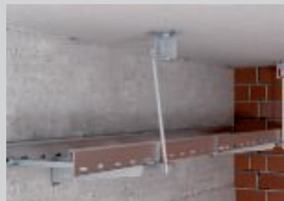
Plafondbevestiging van de draadstangen met brandwerende beugel.
