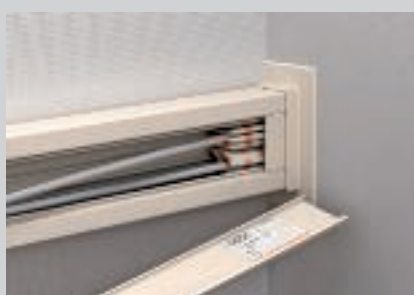
Onopvallend aanbrengen van het identificatieplaatje.
