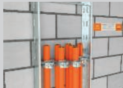
Bevestiging van de kabels afzonderlijk of als bundel met beugelklemmen.
