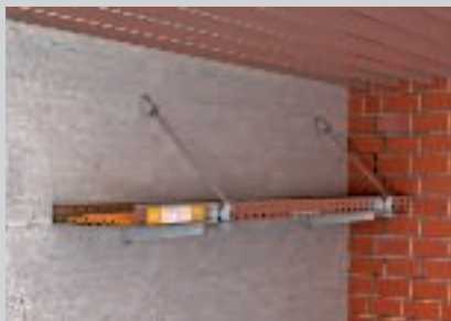
Wandmontage met draadstangborging schuin.
