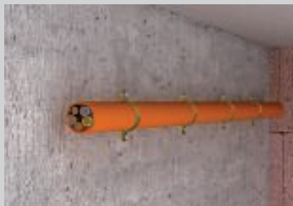
Horizontale montage van de kabels aan de wand.
