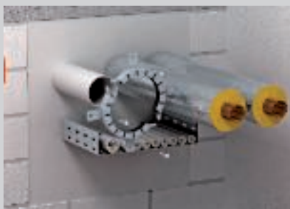
Buismanchetten voor brandbare buizen aan beide zijden van de wand monteren.
