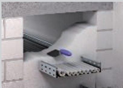
Mortel in de opening aanbrengen, eventueel bekisting gebruiken.
