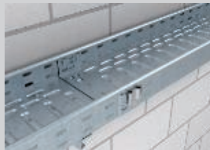
Afgewerkte schroefloze voegverbinding.
