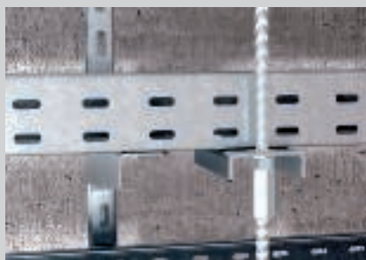
Draadstangbevestiging aan de kabelgoot bij meerlaagse opstelling
