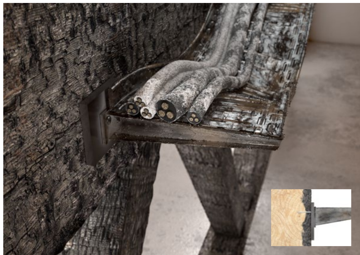
Installation sur une structure portante en bois après un incendie
